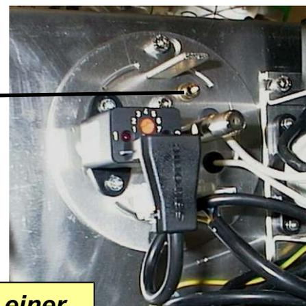
***Der Gebläsedruck ist grundsätzlich mit einer U-Säule bei Brennerbetrieb zu messen***
